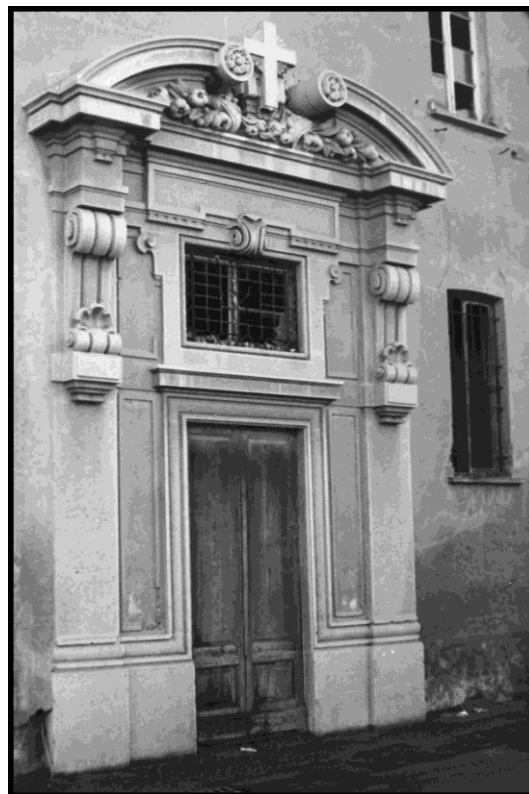
Il portale della ex chiesetta della villa.
