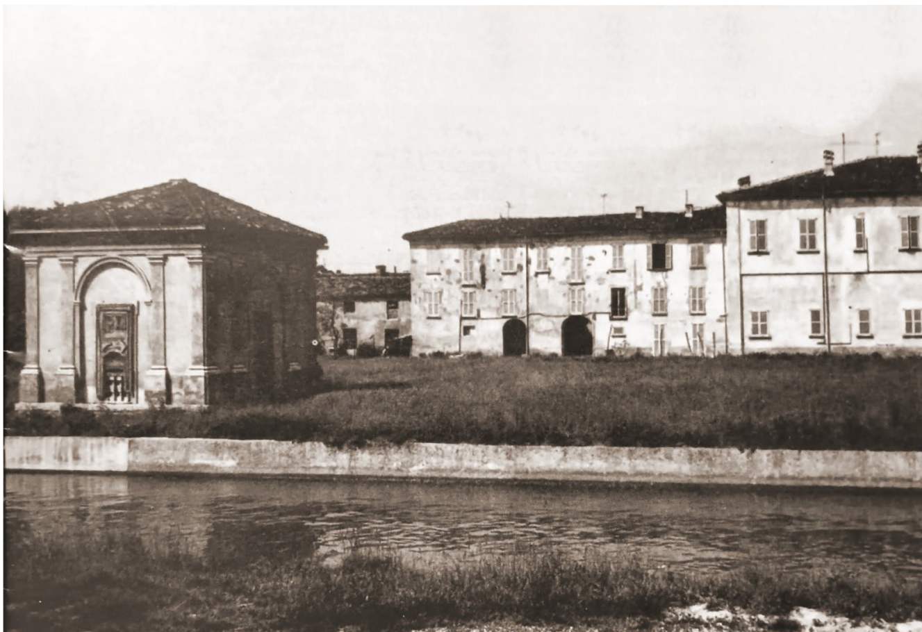
Lato Sud della Villa con affaccio sul naviglio Martesana. In primo piano la piccola costruzione a pianta quadrata chiamata "Cafè-haus", dove i signori ed i loro ospiti, un tempo, prendevano il caffè vicino al canale.
