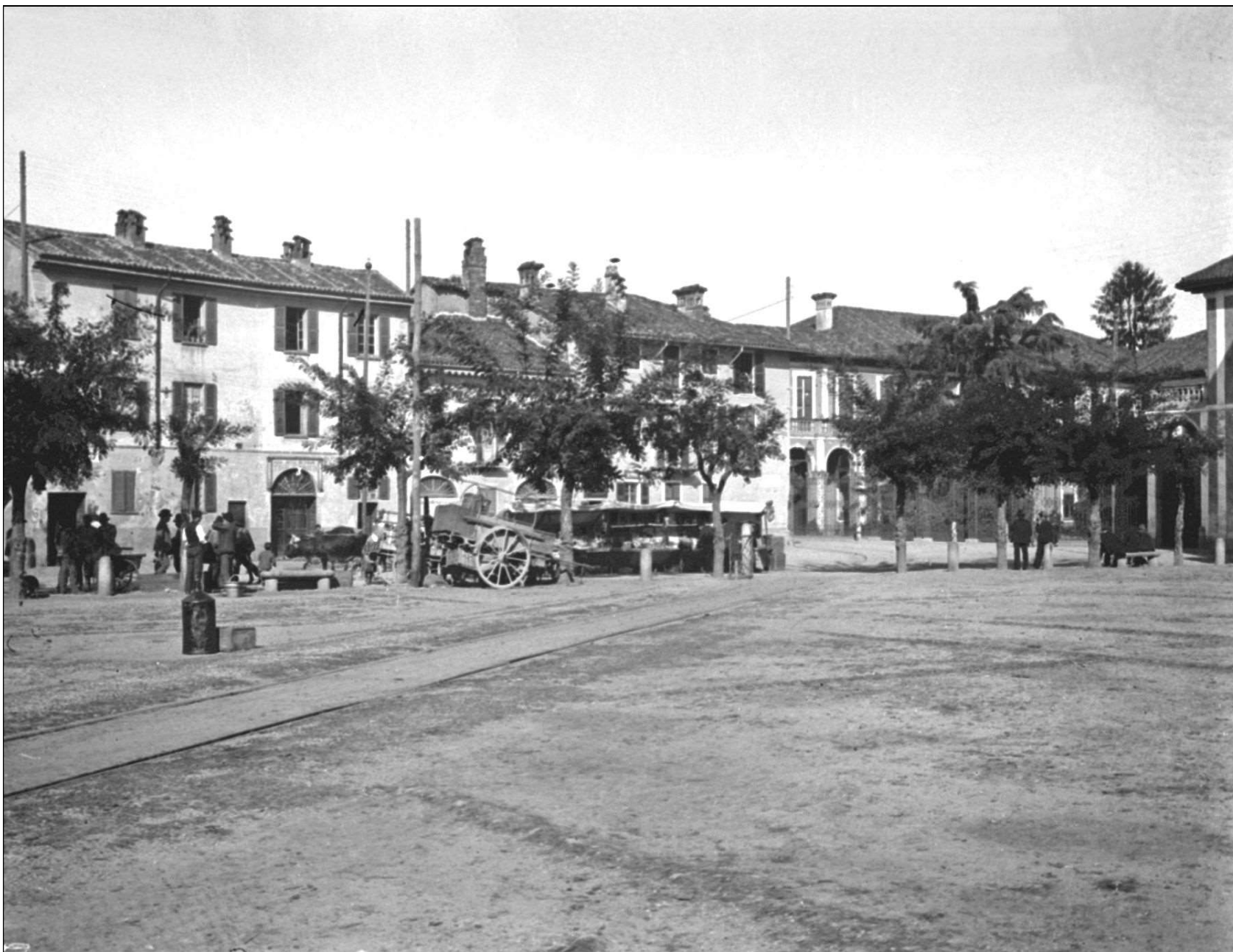
In questa fotografia si vede il tratto rettilineo dei binari che attraversavano diagonalmente la piazza di Inzago. Nel centro della piazza vi era la fermata principale del tram a Inzago.
