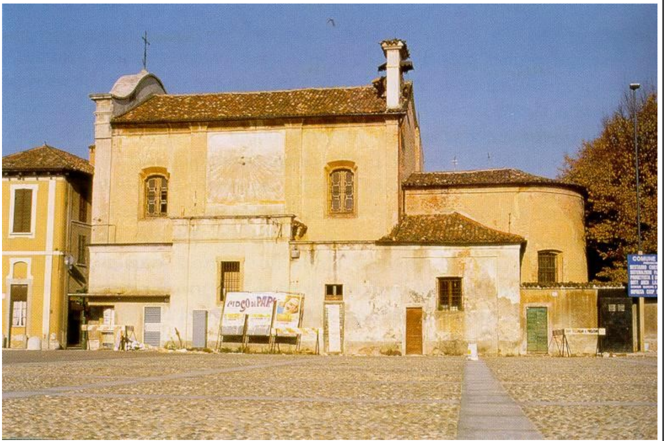
La chiesa di S. Rocco di Inzago prima dei restauri del 1987
