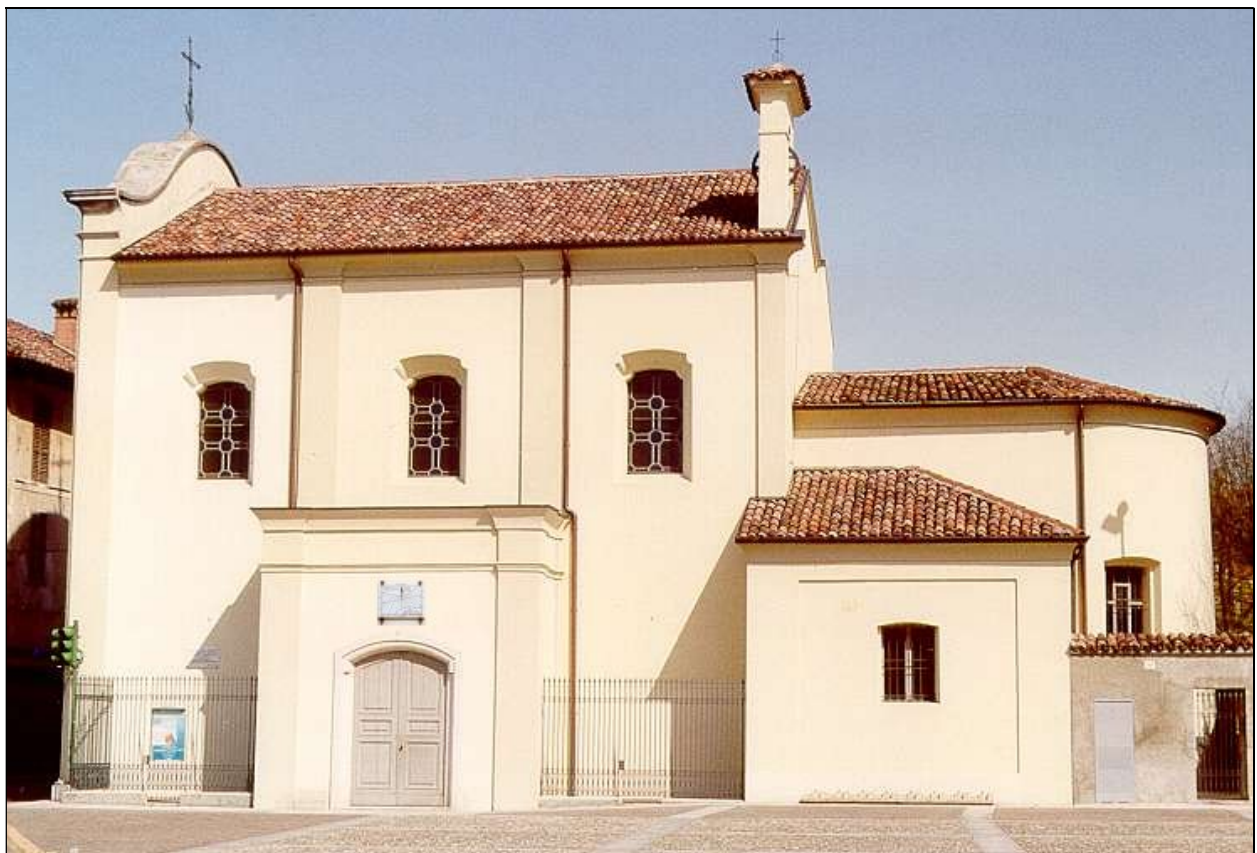
Le fotografie della fase costruttiva sono tutte di Silvano Pirota, ad esclusione della penultima (quella con la bicicletta a fianco dell'ingresso della chiesa), che è di M. Florio
