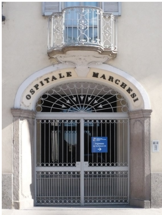
Palazzo Marchesi - Il portale di ingresso
