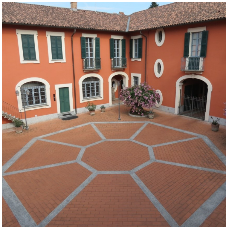
Casa Bollani - La facciata interna dopo la ristrutturazione edilizia
