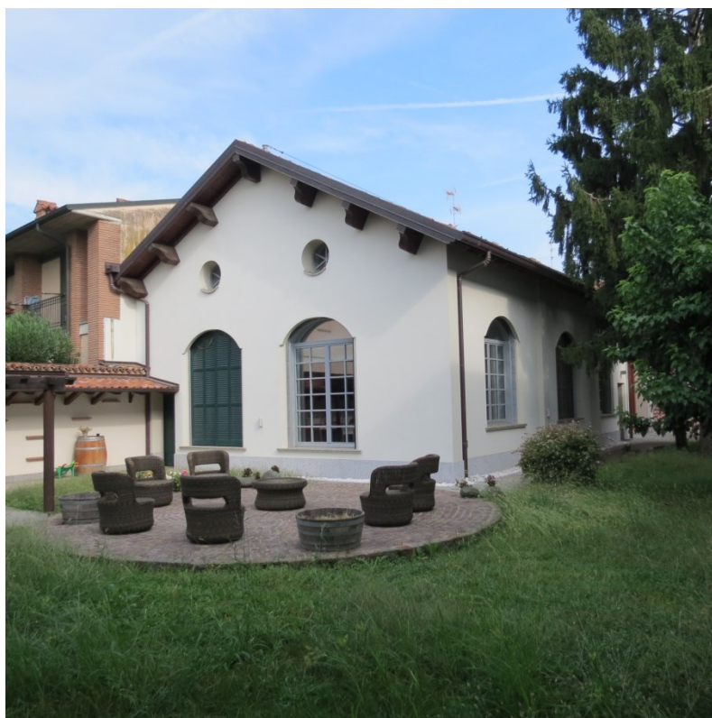
La ex filanda Bollani prima e dopo l'intervento di restauro con risanamento conservativo (2011-2012)
