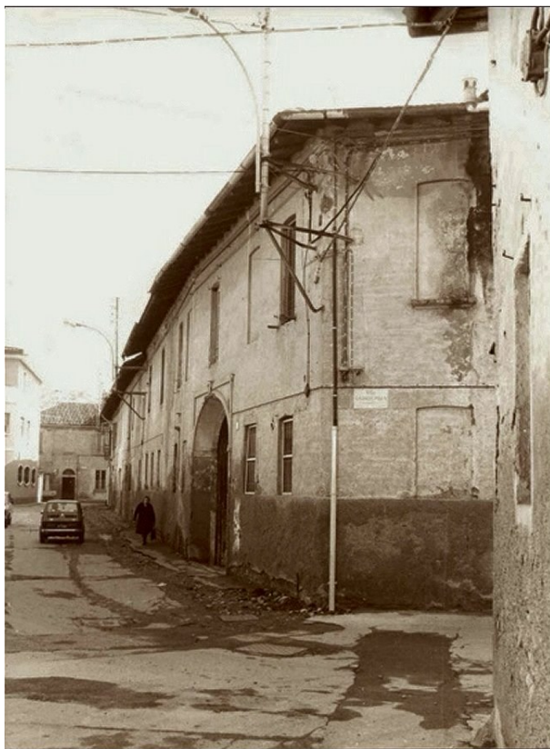
Edifici rustici Dell'Orto lungo Via Fumagalli prima dell'abbattimento
