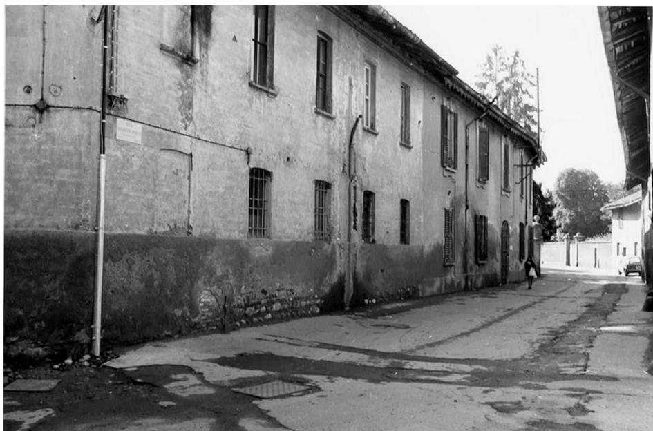
Edifici rustici Dell'Orto lungo Via Piola prima dell'abbattimento
