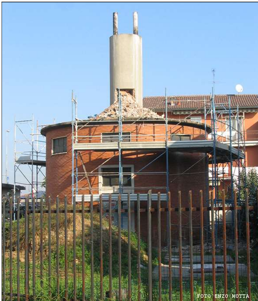
Alcune fasi della demolizione della parte aerea della torre.
