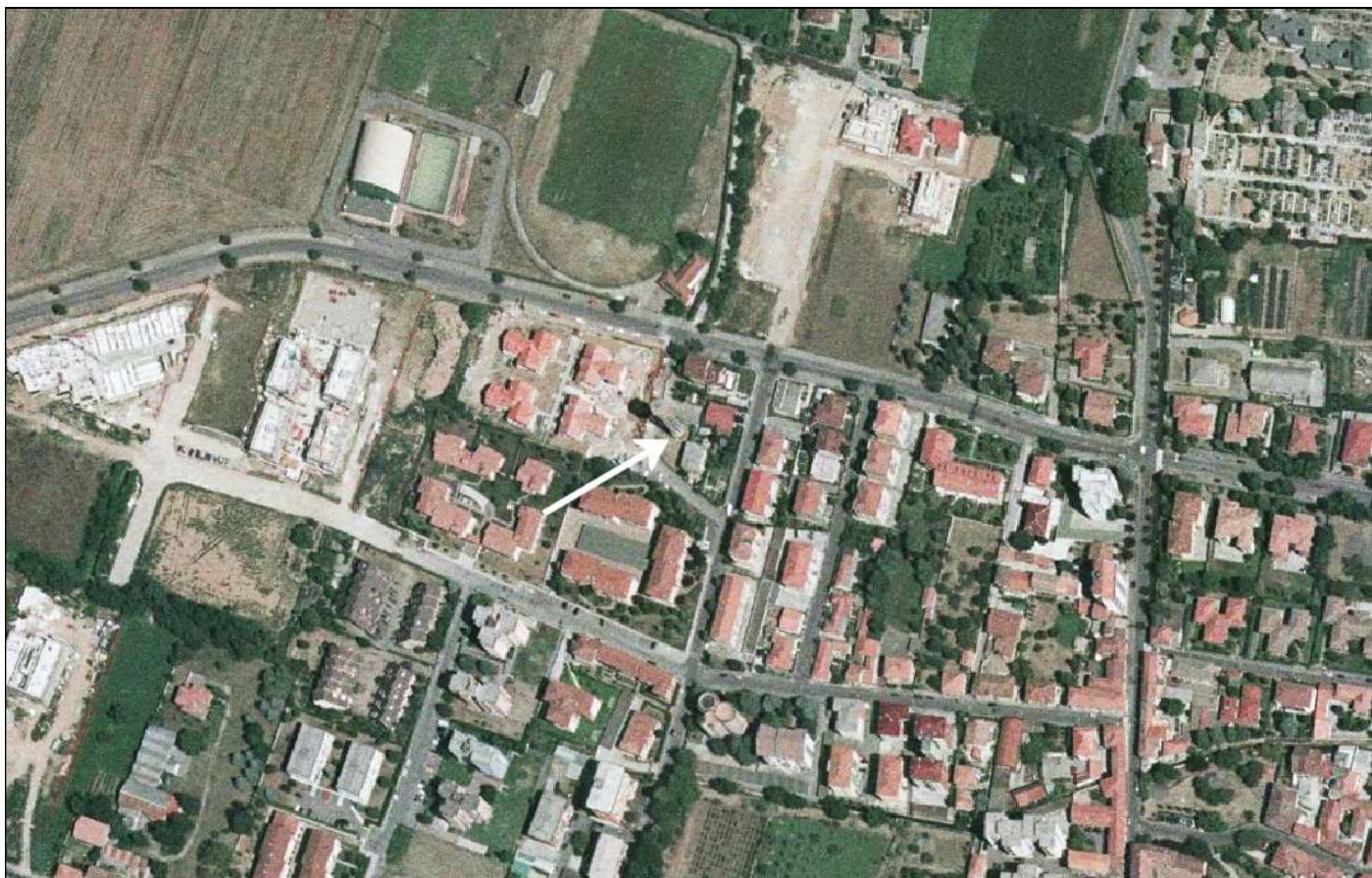
Nelle immagini satellitari datate 2003, a una scala di 1:2500, la torre piezometrica è ancora presente in tutta la sua altezza, proiettando un'evidente ombra sul terreno (la fotografia è stata scattata di mattina).
