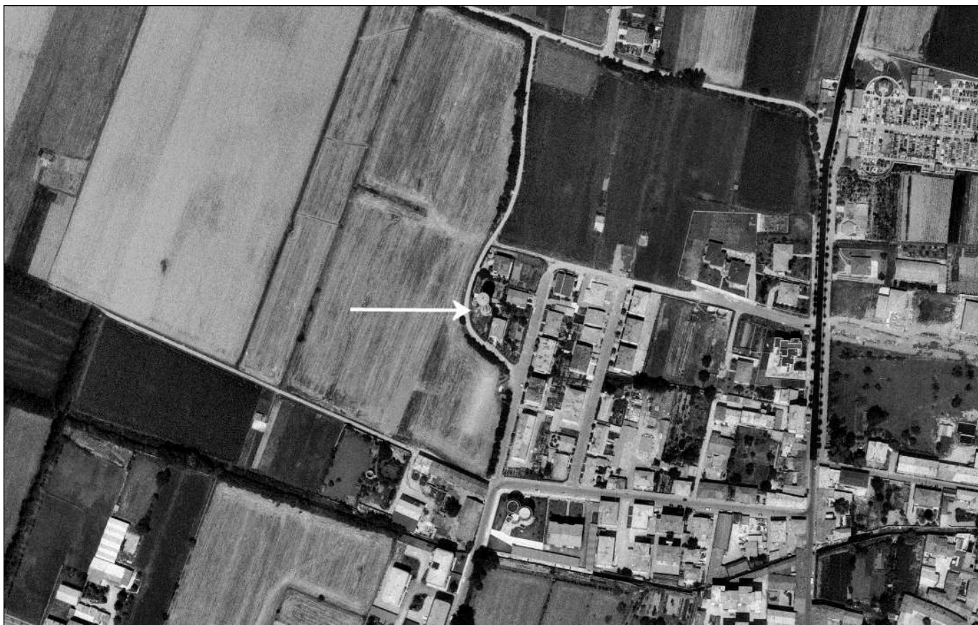
La torre piezometrica in zona cascina Giulia nelle fotografie aeree del 1975, a una scala di 1:2500, con la freccia bianca a indicare la posizione della torre.
