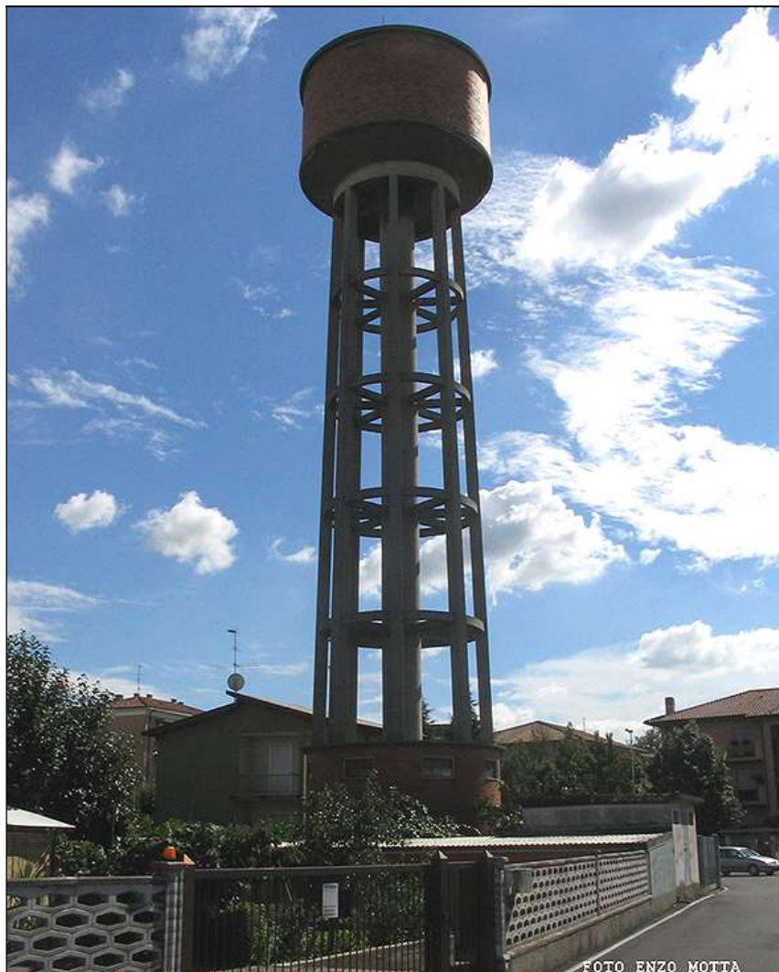
Un paio di fotografie prese da due angolazioni diverse, della torre piezometrica della cascina Giulia.
