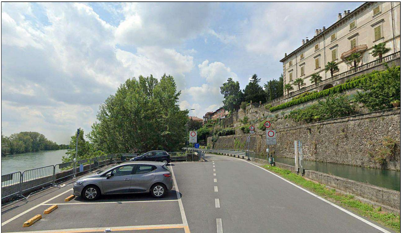
Fig. 11 - Il naviglio della Martesana corre sospeso a mezz'altezza tra il fiume Adda, che si trova a una quota inferiore lungo il suo fianco Est e la villa Melzi d'Eril arroccata in cima all'alta sponda di Vaprio d'Adda, a Ovest del fiume. L'inquadratura dello scatto fotografico è da Nord in direzione Sud
