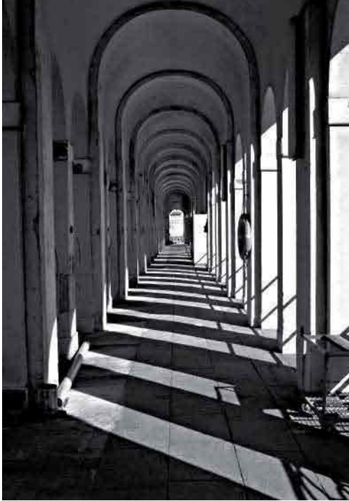
Corridoio interno all'opera di presa
