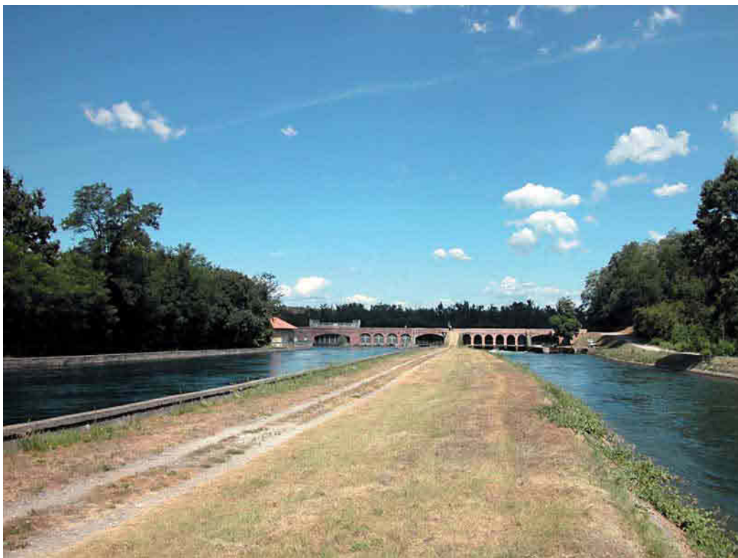
Digue del Panperduto, località Maddalena, incile del canale Villoresi (a destra) e del canale Industriale, dalle cui acque origina il Naviglio Grande
