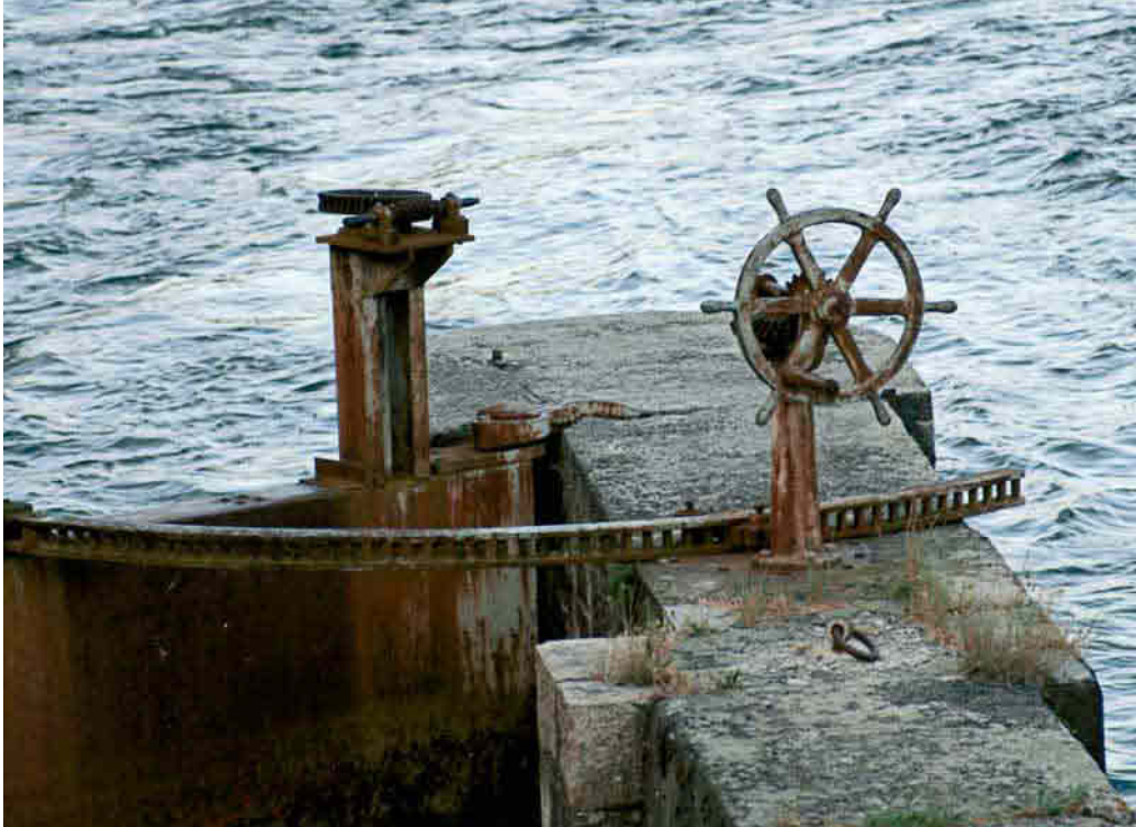
Particolare della conca di navigazione principale
