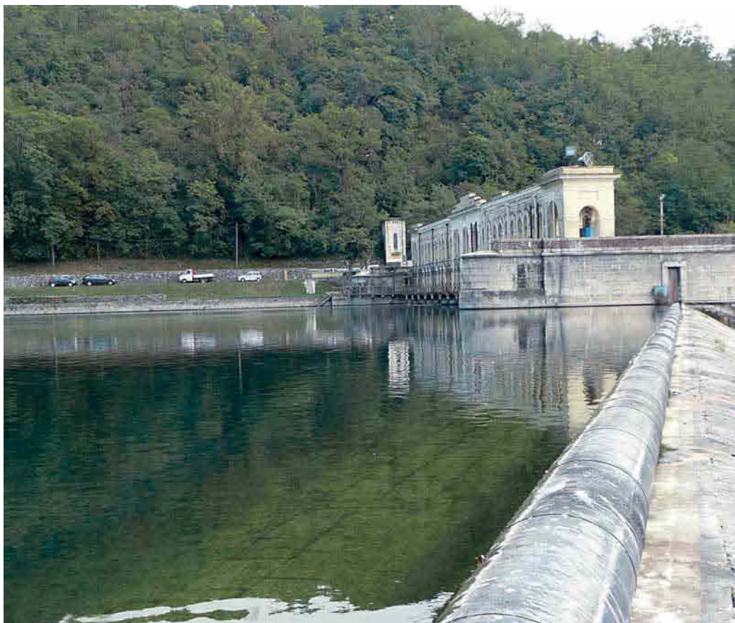
Dighe del Panperduto: bacino di monte con in primo piano il sistema per la regolazione della traversa (gomrone)
