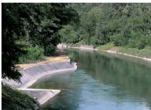
Canale Villoresi a Tornavento
