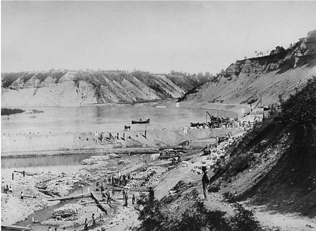
Qui e a fronte, immagini del “colossale” cantiere, 1882-1884
