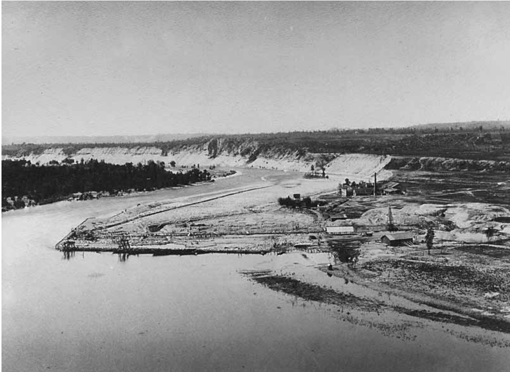
Lavori di costruzione alle Dighe del Panperduto, 1882-1884
